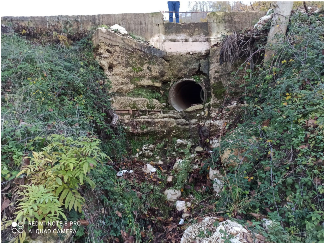
Figura 2: Vista da valle attraversamento
