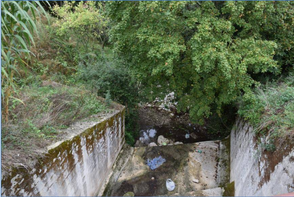
Foto n. 8: III tratto, Ponte n.2 – Ponte n. 3, Loc. Campo lo Piano, particolare stato dei luoghi all'interno del vallone, dal ponte n.3
