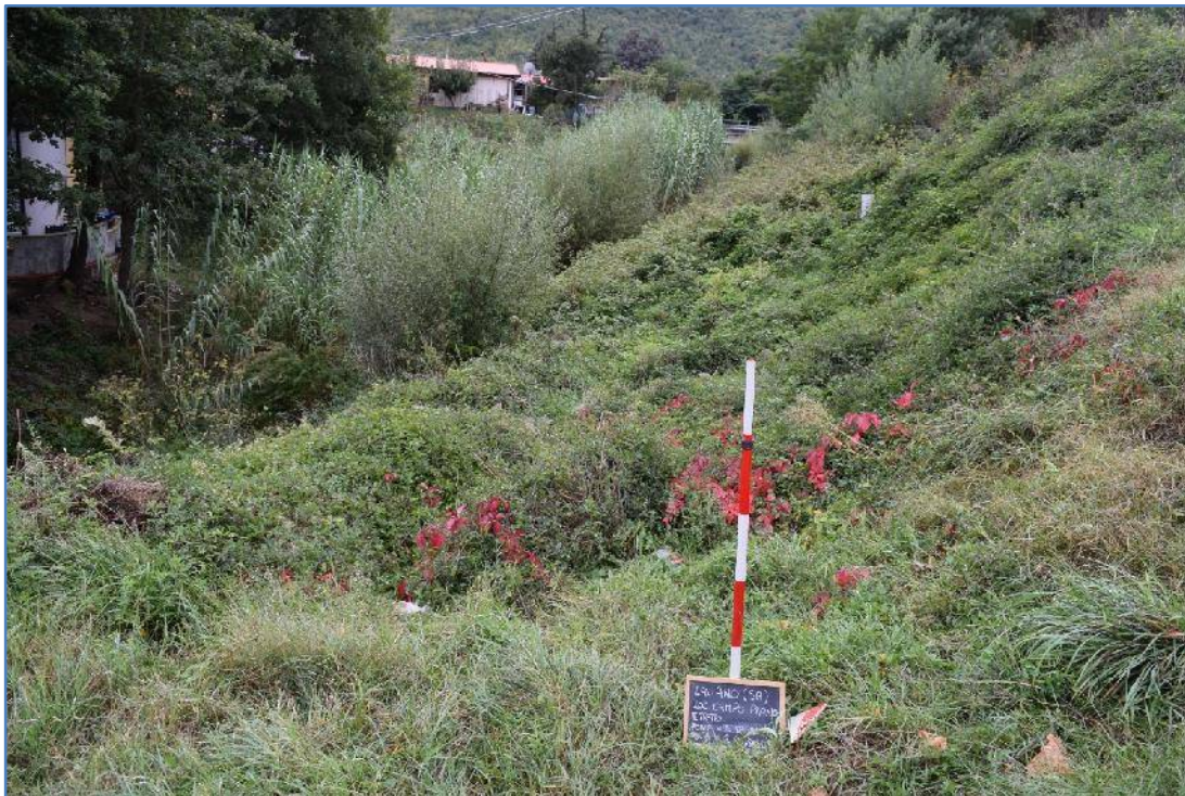
Foto n. 4: Il tratto, Ponte n.1 SP381 – Ponte n. 2, particolare stato dei luoghi all'interno e ad immediato ridosso del vallone.
