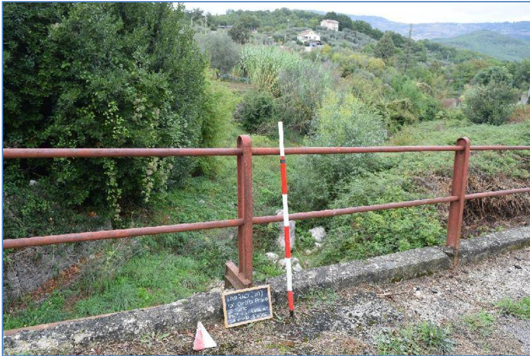
Foto n. 9: IV tratto, Ponte n.3 – Ponte n. 4 San Donato, particolare stato dei luoghi, dal ponte n.4 San Donato.
