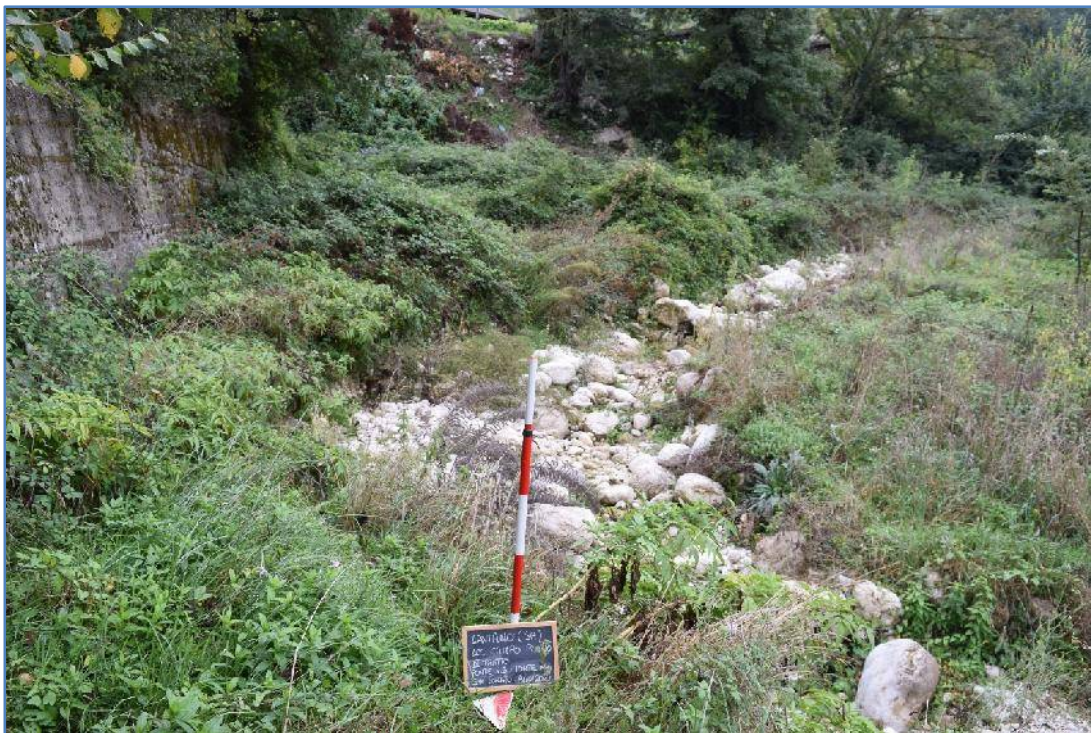
Foto n. 9: IV tratto, Ponte n.3 – Ponte n. 4 San Donato, particolare stato dei luoghi all'interno e ad immediato ridosso del vallone.
