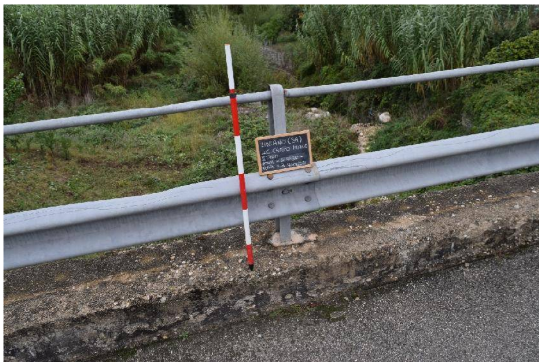
Foto n. 5: Il tratto, Ponte n.1 SP381 – Ponte n. 2, particolare stato dei luoghi all'interno e ad immediato ridosso del vallone, dal ponte n. 2.
