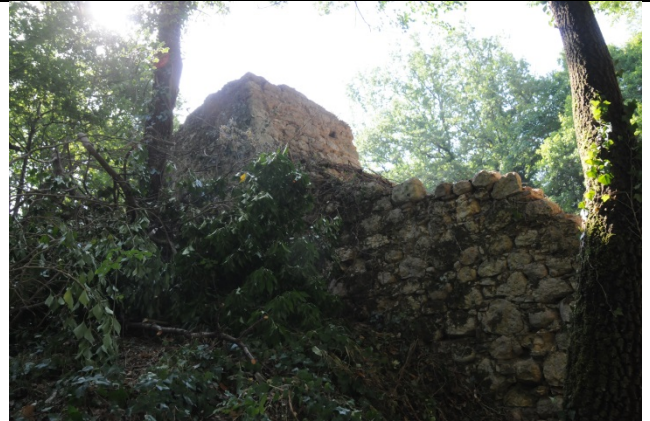
Vista da nord-est (insieme)
