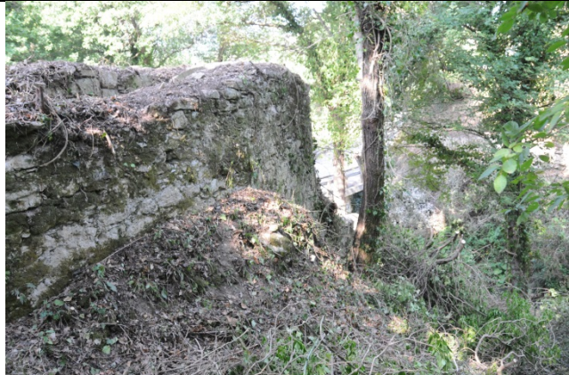
Vista da nord-est (torre di adduzione)
