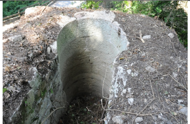
Particolare torre di adduzione
