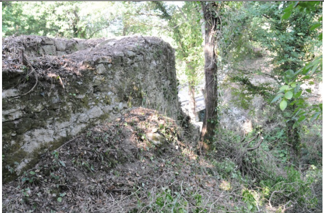
Vista da nord-est (torre di adduzione)
