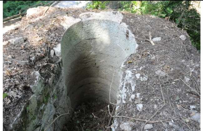
Particolare torre di adduzione
