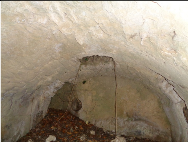
particolare interno camera con sbocco canale di adduzione
