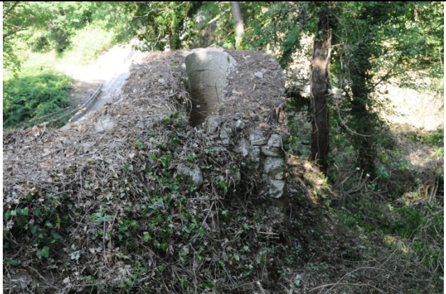
Vista da est ( canale parziale e torre di adduzione)
